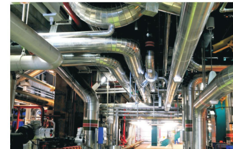
管道安装工艺标准样品
