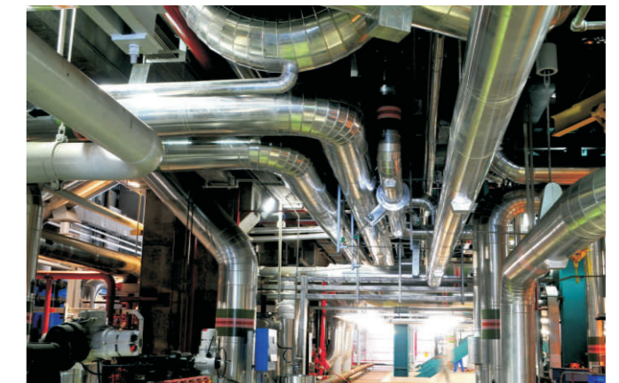
管道安装工艺标准样品
